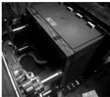
写真-7 掘進状況
