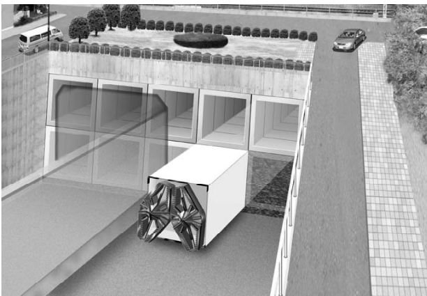
図-1 大断面分割シールドのイメージ
