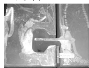
写真-2 I型継手
