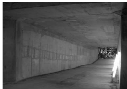
写真-11 構築完了（鋼殻切断，止水完了）
