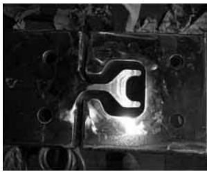
写真-3 継手部状況 (掘削完了時)
