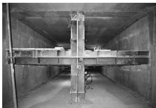
写真-10 構築終了（鋼殻撤去前）
