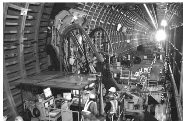
写真-14 富ヶ谷出入口トンネル太径曲線パイプルーフ施工状況
