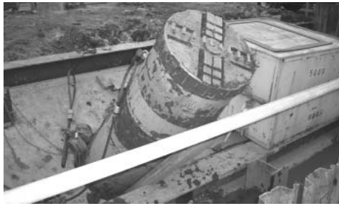
写真-5 太径曲線掘削機到達状況
