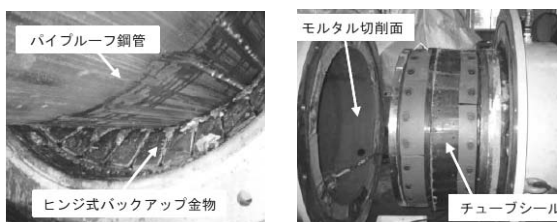
写真-9 発進エントランス 写真-10 到達エントランス
