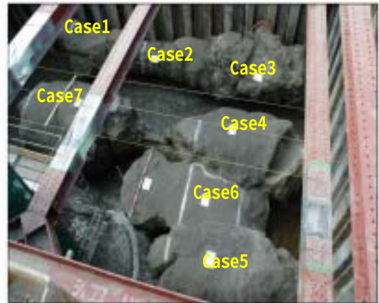
写真-2 掘出した改良体
