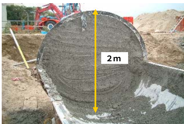
写真-6 密閉充填状況
