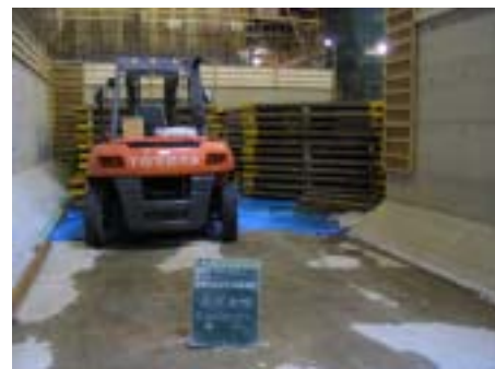
写真-1 敷鉄板積上げ状況
