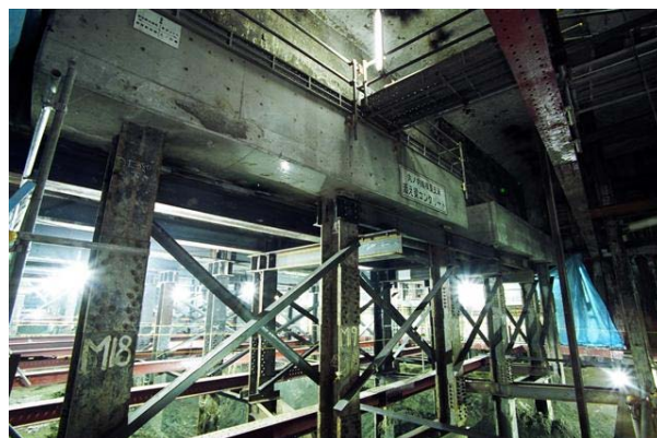
写真-2 下受工完了状況
