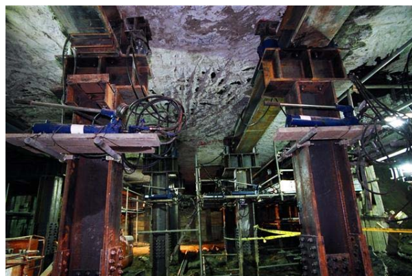
写真-1 プレロード施工状況
