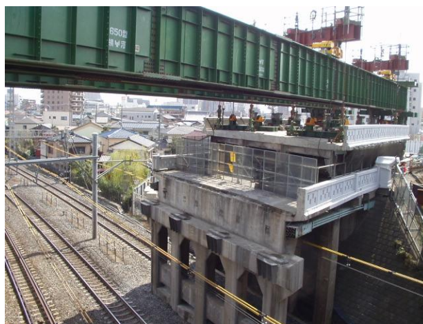
写真-5 夜間縦取り移動完了
