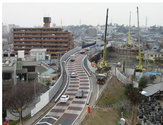
写真-12 海神こ線橋撤去後
