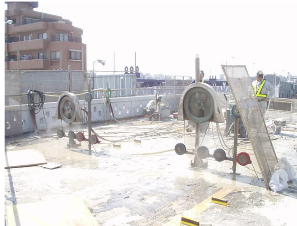
写真-6 ワイヤーソウ切断状況
