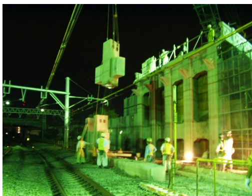
写真-10 線路間橋台撤去状況
