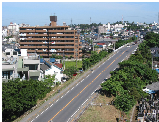
写真-11 海神こ線橋撤去前
