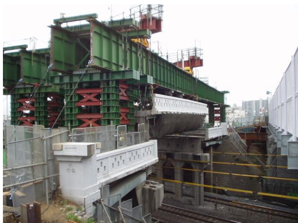
写真-4 夜間ジャッキアップ完了
