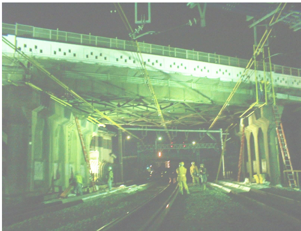
写真-2 桁下足場組立て状況
