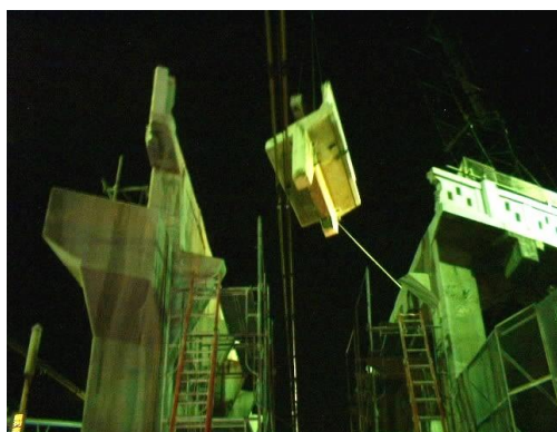
写真-8 線路直上部撤去状況
