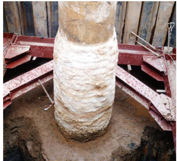
写真-4 鋼管と場所打ち杭との接合部
