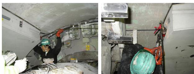
写真-2 PC鋼線の挿入と緊張作業
