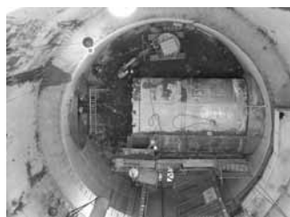
【写真 3】隔壁撤去状況
