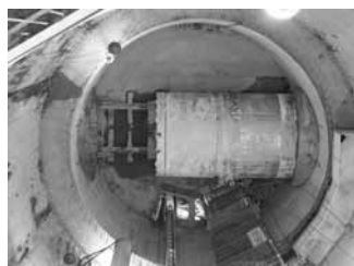
【写真 4】撤去完了
