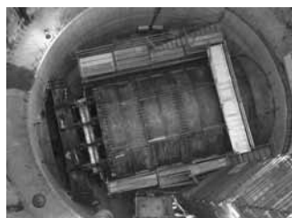
【写真 2】隔壁組立完了
