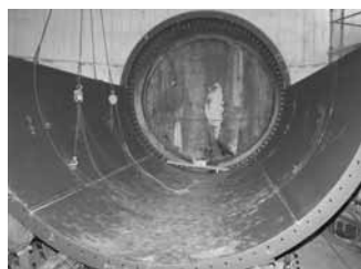
【写真 1】隔壁組立状況
