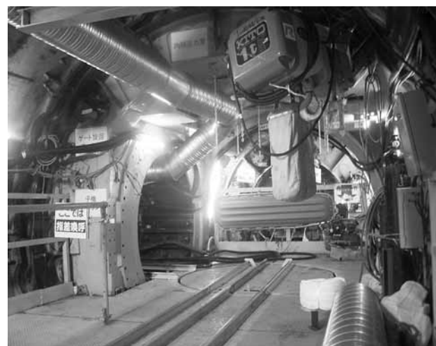
【写真9】 分岐発進完了状況
