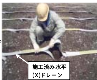
図-6 ネットワークドレーン工法の施工フロー
