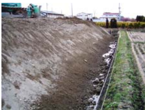
写真-4 サンドマットからの排水状況 (サンドマット併用法側)
