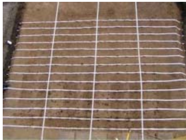
写真-3 施工ヤードの全景 (ネットワークドレーン工法側)
