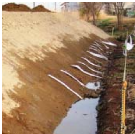
写真-5 水平ドレーンからの排水状況 (ネットワークドレーン工法側)
