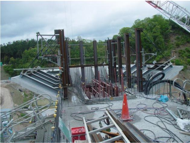
写真-5 取水塔張出部のプレキャスト型枠（厚肉）
