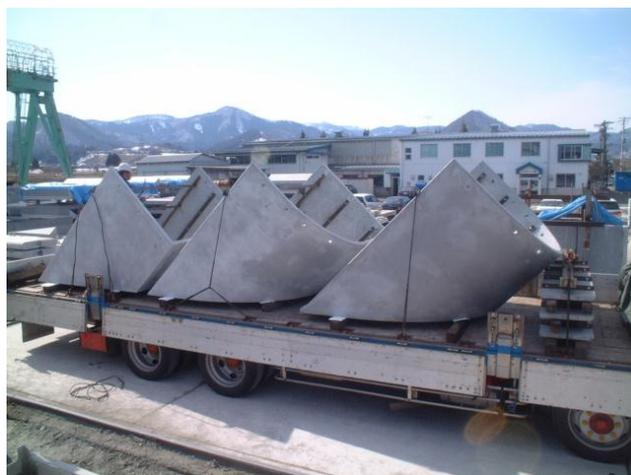
写真-3 プレキャスト型枠搬入（薄肉）
