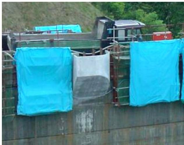
写真-4 アバット部のプレキャスト型枠（薄肉）
