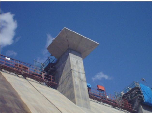
写真-6 水位計測塔張出部のプレキャスト型枠（厚肉）
