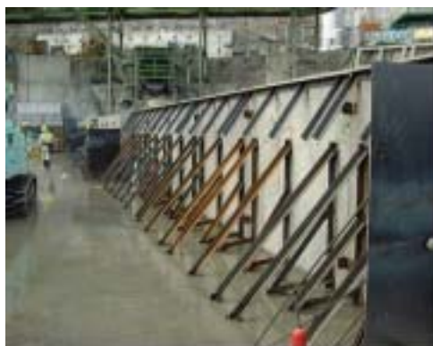
写真-6 勾配変化部プレキャスト型枠
