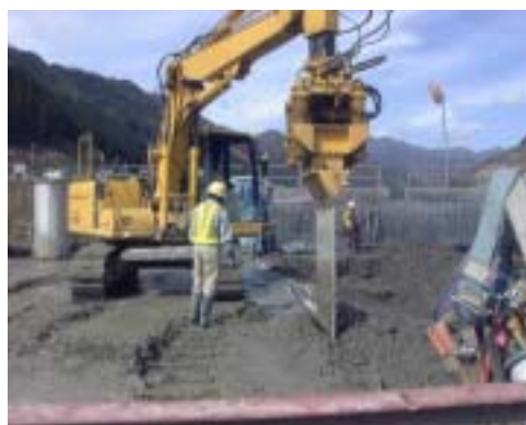
写真-9 1.5m用目地切り機稼動状況
