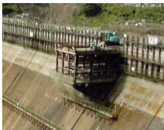
写真-5 下流面張出し架台
