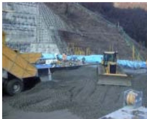
写真-8 ブルドーザによる敷均し状況
