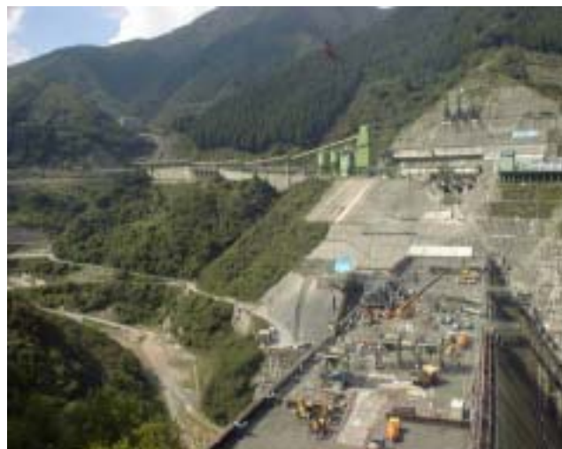
写真-1 施工設備全景
