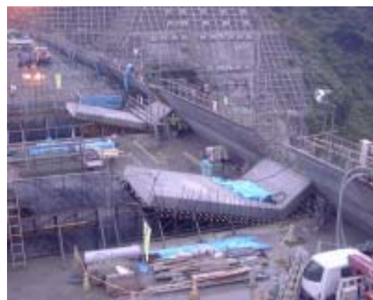
写真-4 吐口頂部プレキャストブロック
