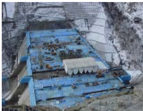
写真-2 打設面養生状況（2002年度）
