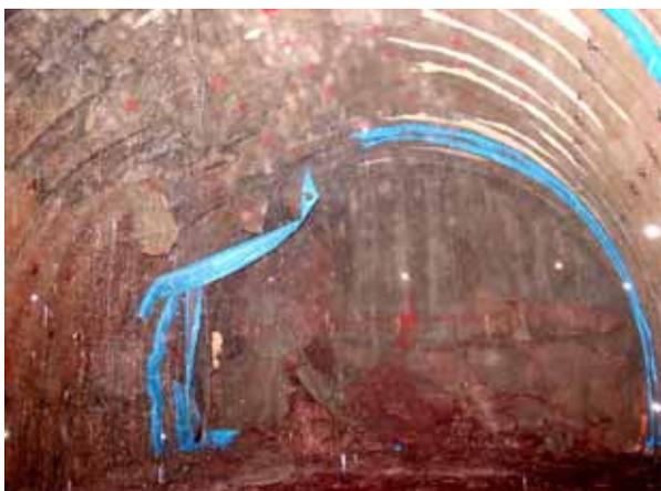
写真-1 第 1 回変状状況 (支保工崩壊)
