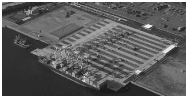
図-19 名古屋港飛島ふ頭南側コンテナターミナル第1バース（平成17年12月完成）
