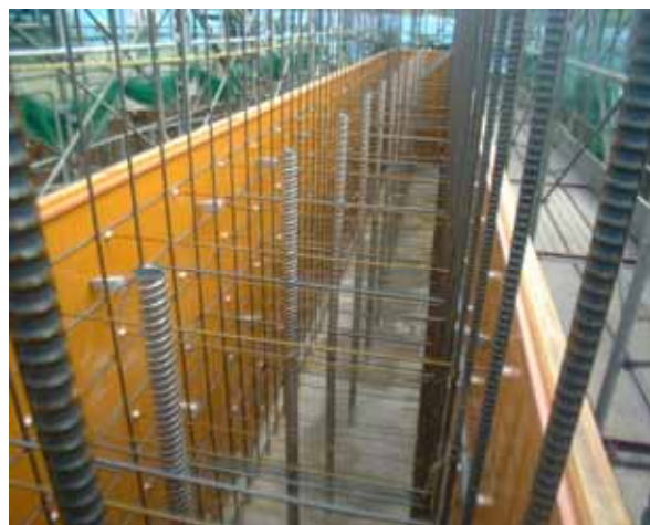
写真-1 シース管取付状況
