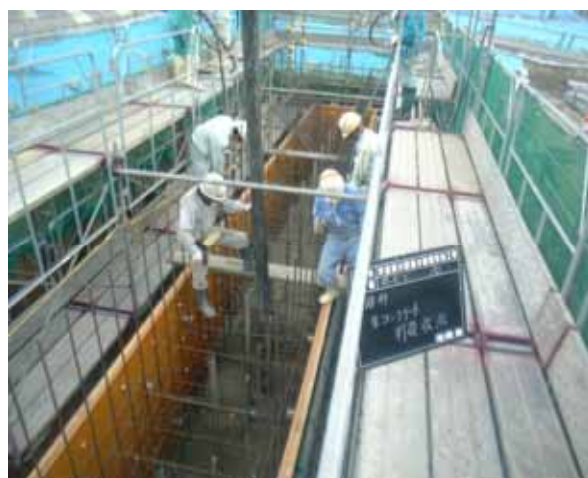
写真-2 コンクリート打込み状況
