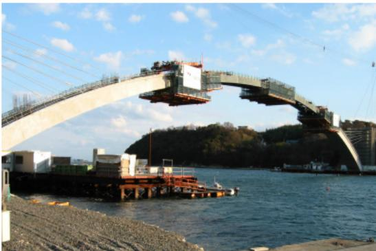
写真-8 メラン材クラウン部施工状況
