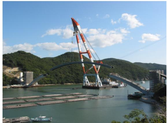
写真-5 メラン材架設状況
