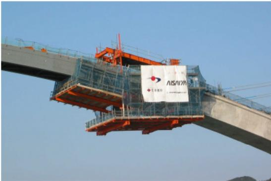
写真-7 メラン材コンクリート巻き立て状況
