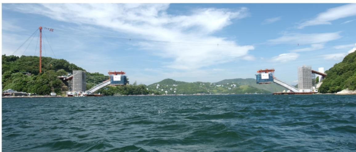
写真-2 新ピロン工法施工状況
