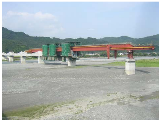
写真-2 架設桁送り出し
