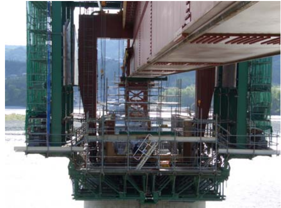
写真-4 柱頭部吊枠支保工
