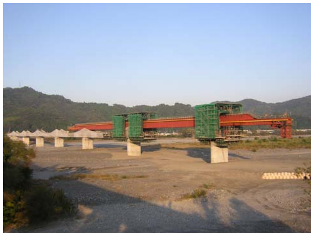
写真-1 移動架設桁全景
