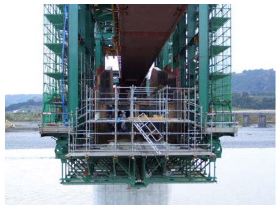
写真-4 柱頭部吊枠支保工
