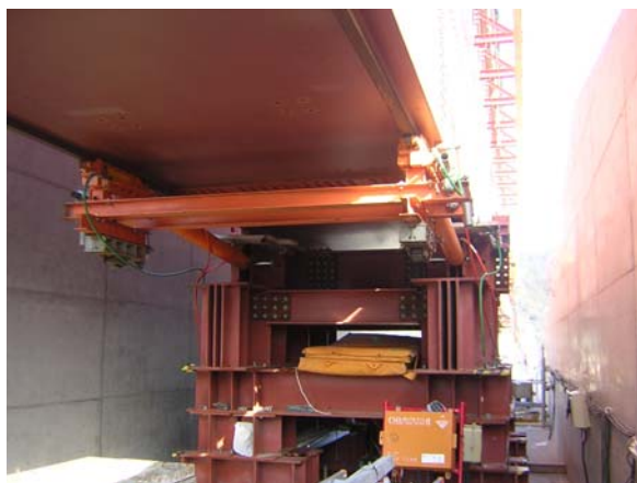
写真－3 鋼製すべり架台と水平ジャッキ
