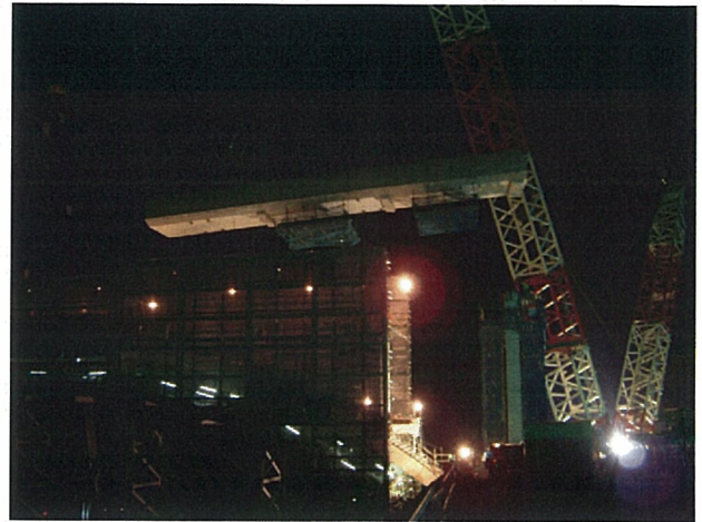
写真-4 床版④撤去状況
