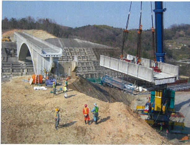
写真-2 端部床版撤去状況
