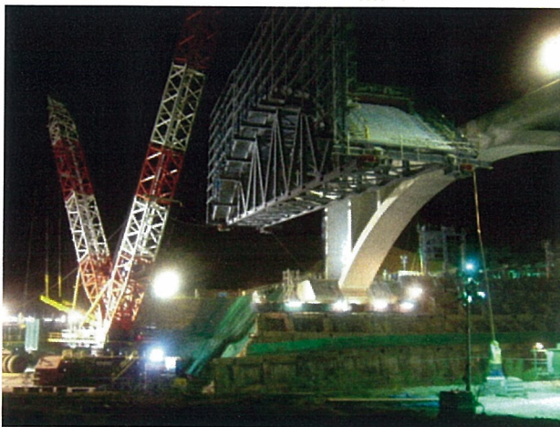
写真-3 仮設支保工の架設状況
