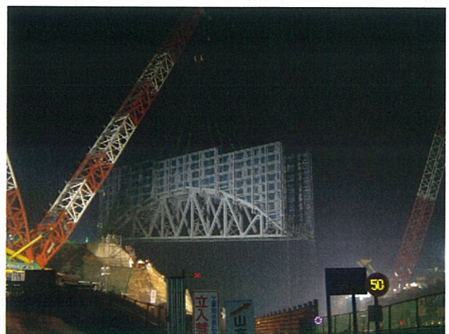
写真-5 仮設支保工の撤去状況
