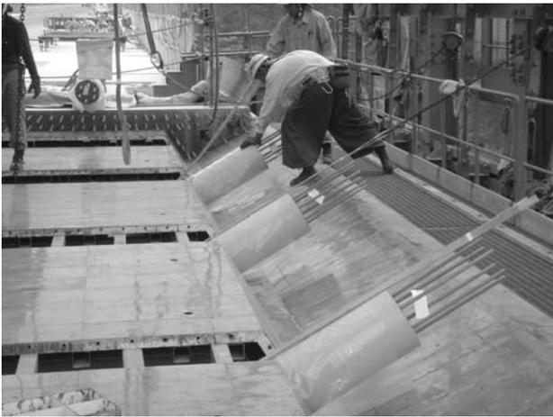
写真-10 ストラットの取付け
