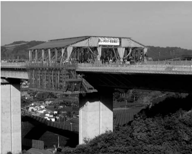
写真-9 専用移動作業車
