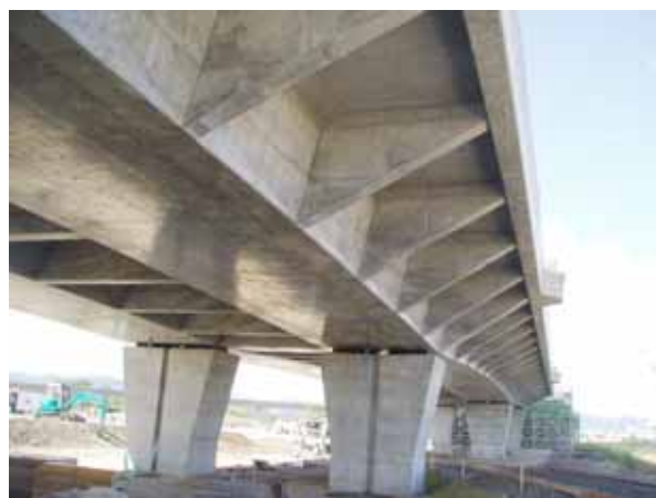
写真-2 完成写真
