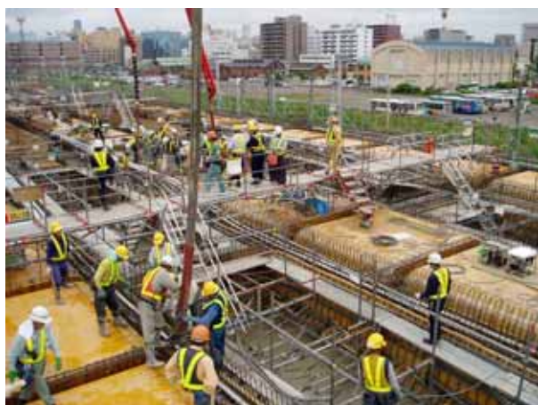
写真-1 コンクリート打設状況
