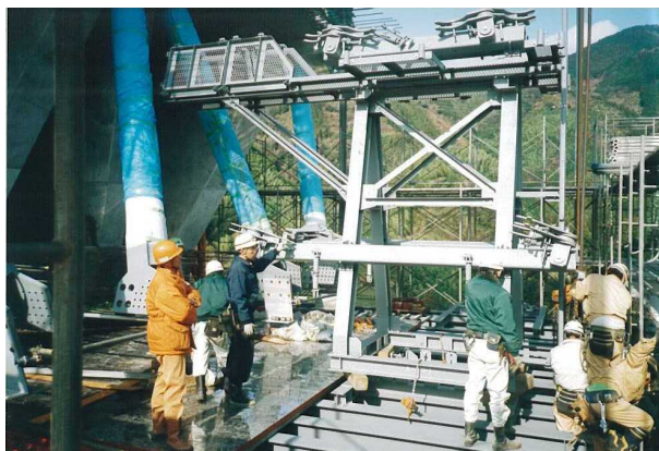
写真-4 トラス受架台
