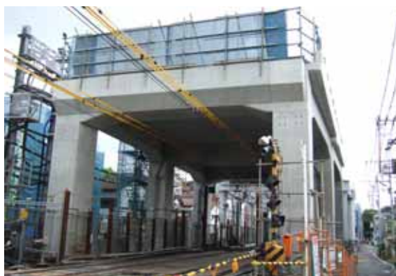
写真-8 施工完了
