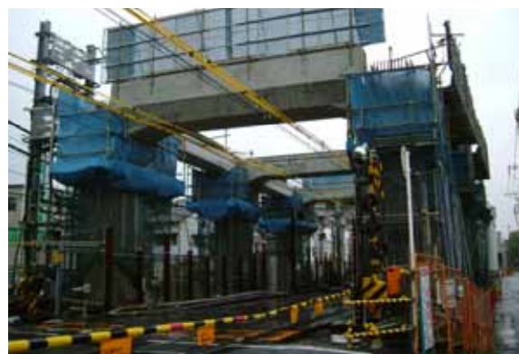
写真-7 梁架設完了
