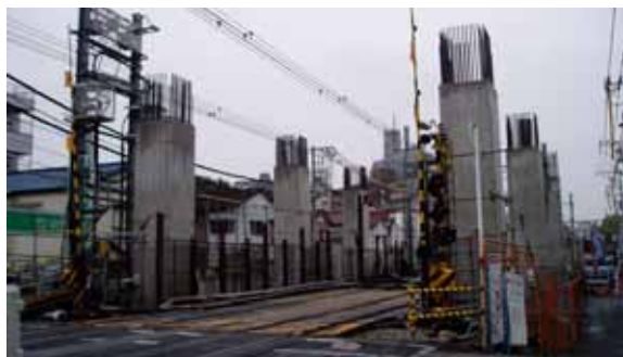
写真-5 柱施工完了
