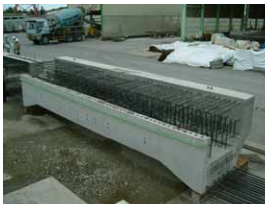
写真-1 端横梁部材
