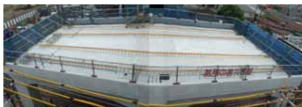
写真-13 施工完了
