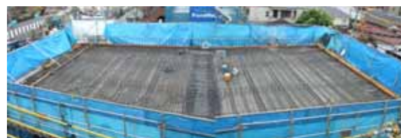
写真-11 配筋完了
