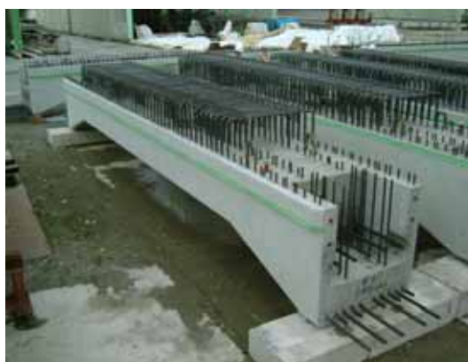
写真-3 縦梁部材
