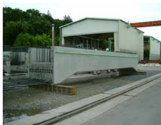
写真-2 中間横梁部材
