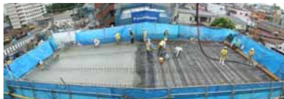
写真-12 コンクリート打設状況
