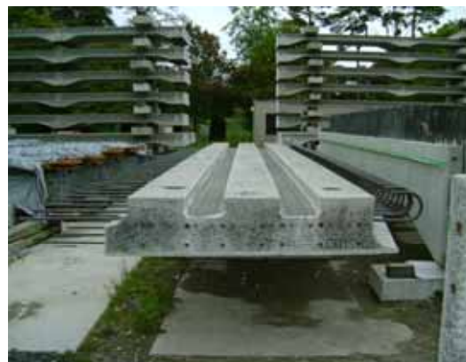
写真-4 スラブ部材
