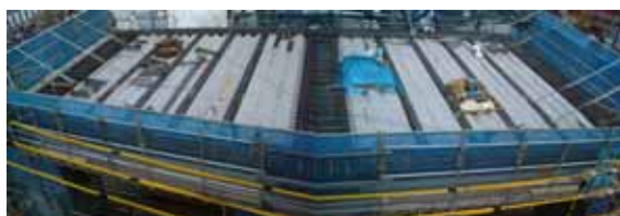
写真-10 スラブ架設完了
