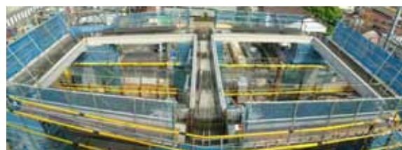
写真-9 梁架設完了
