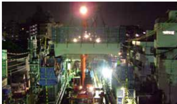
写真-6 梁架設状況
