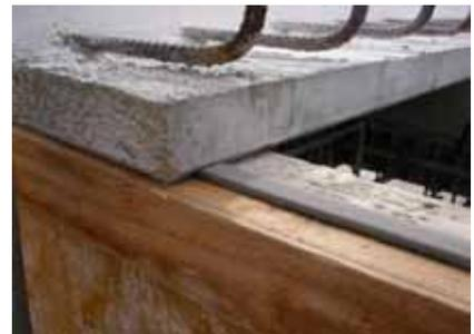
写真-10 微調整時のシール材
