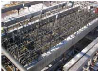
写真-13 帽子桁スラブの設置
