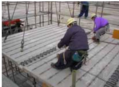
写真-9 設置位置の微調整
