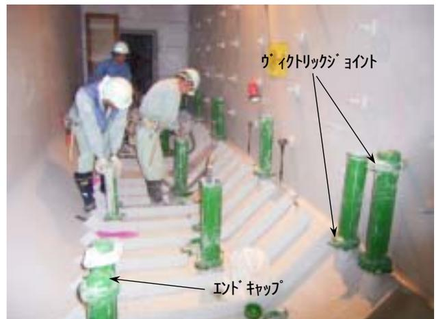
写真-4 側道下部打設状況
