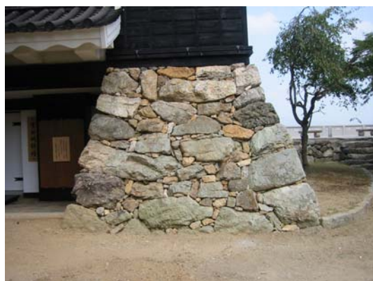
補修後：間詰石の補充と割れ石等の交換を実施した
