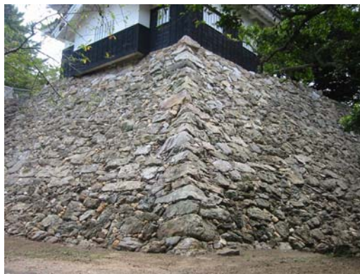
写真-1 吉田城鉄櫓と石垣（補修後）
