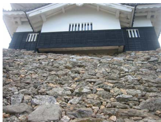
補修後：間詰石が補充され、櫓直下の石積みも整備され、石垣全体の安定性が向上した
