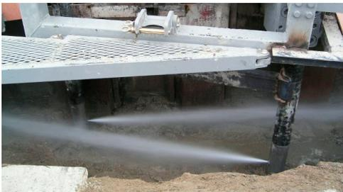
写真-2 多軸揺動ジェット噴射状況
