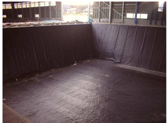
写真-9 負圧検査の状況の例
