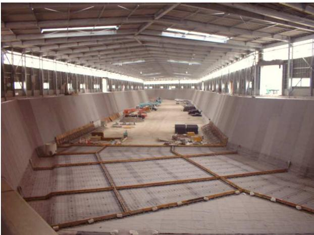
写真-3 奥：保護コンクリート設置状況
