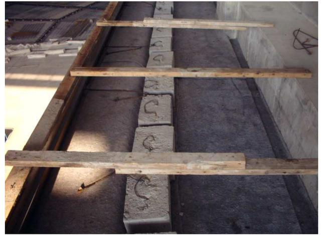
写真-6 仮固定用ブロックの設置状況
