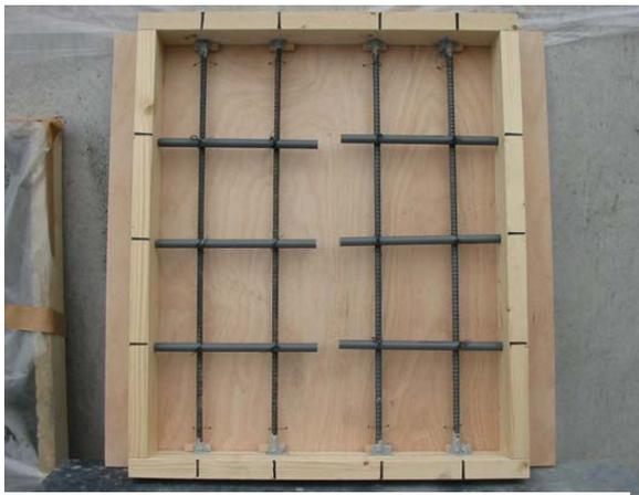
写真-4 吹付け型枠
