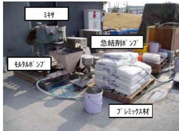
写真-3 吹付け資機材の配置例
