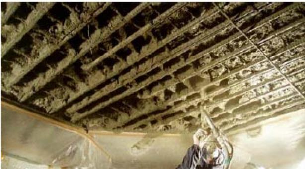
写真-2 鉄筋背面への充てん状況
