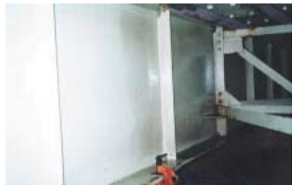
a) 簡易移動足場を用いた人力による洗浄
