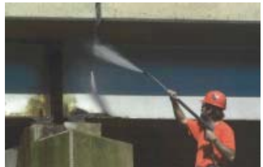
b) 高圧水道水による洗浄
