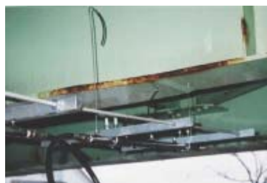
写真-4 簡易洗浄装置の下フランジ部への設置状況
