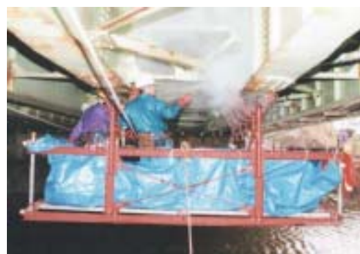
写真-2 簡易移動吊足場を用いた洗浄状況
