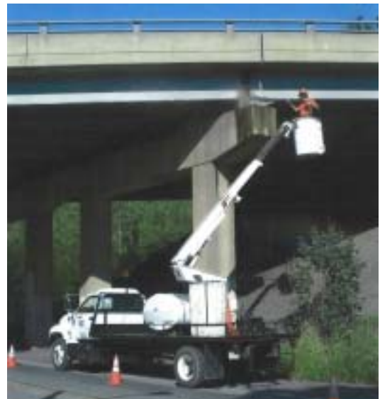
a) 高所作業車を用いた橋梁洗浄
