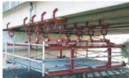
写真-1 簡易移動吊足場
