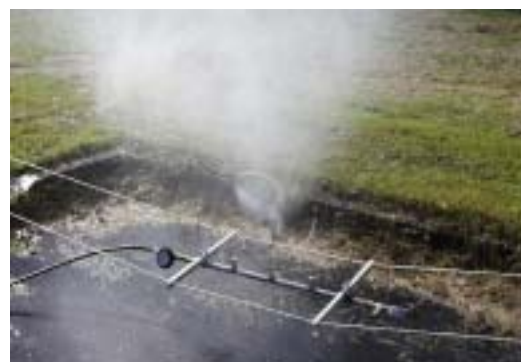
写真-3 チューブノズルを用いた簡易洗浄装置
