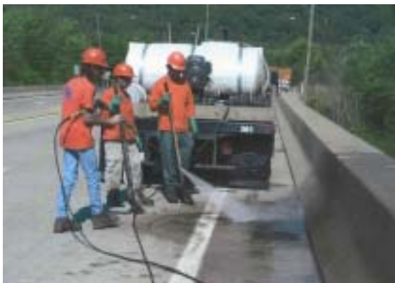
写真-12 排水装置の清掃状況
