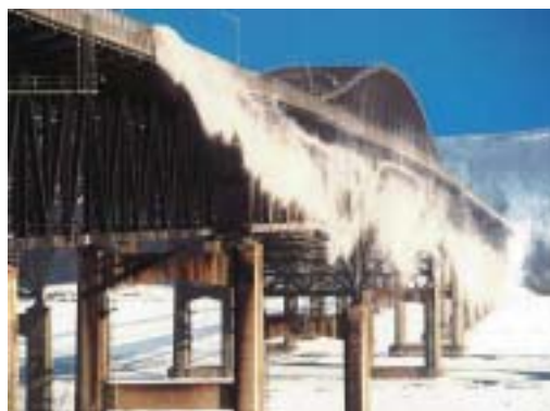
写真-7 除雪中のニューブルグ・ビーコン橋
