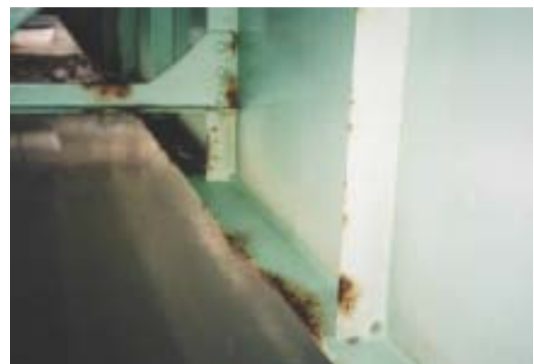
b) 簡易洗浄装置による洗浄
