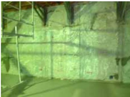
写真-3 壁体仕上り状況 (GL-16.0m付近)
