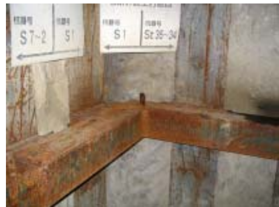
写真 - 1 補強鋼材設置状況
