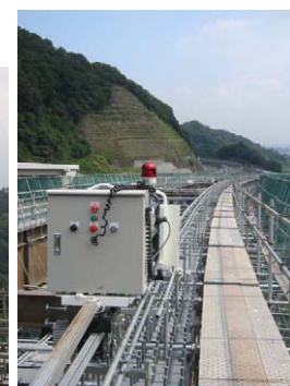
写真-8 レールの設置
