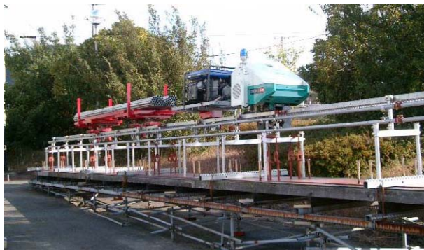
写真-3 走行試験状況（直線桁）
