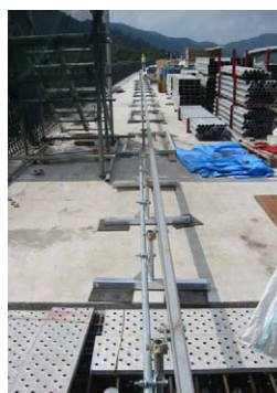
写真-5 既設床版への設置
