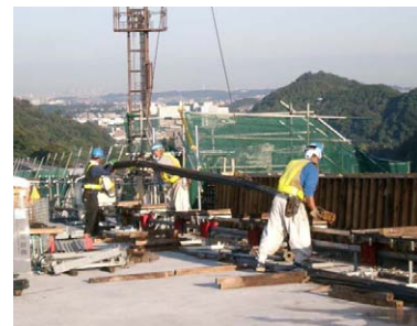
写真-6 資材の積み込み
