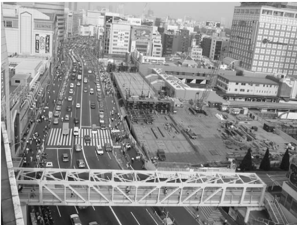
写真-8 平成15年9月 6主桁架設中
