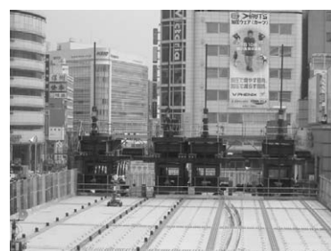
写真-7 ジャッキングホイスによる降下作業
