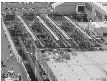
写真-5 手延べ機による送出し作業
