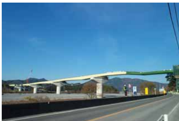
写真-1 送出し状況
