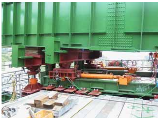
写真-2 手延べ機を支持した送出し装置
