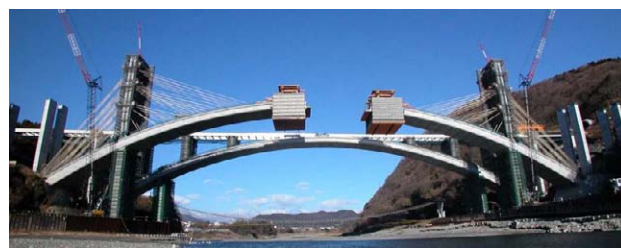
写真-1 アーチリブの張出し状況
