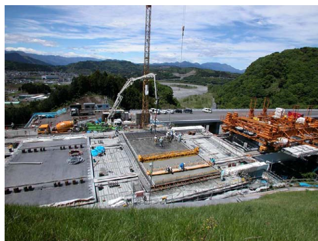
写真-3 床版製作ヤード
