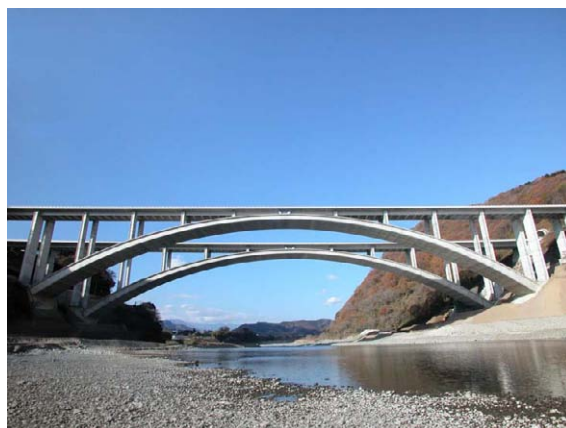
写真-5 完成写真（平成16年12月）
