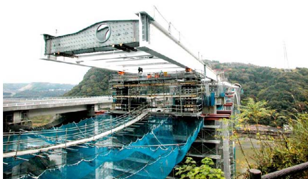
写真-2 鋼桁架設状況
