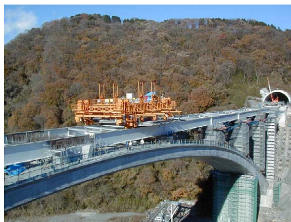
写真-4 床版架設状況
