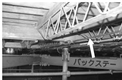
写真-4 バックステーによる主桁間の引寄せ(床版裏)
