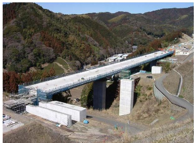
写真-7 張出し床版施工完了
