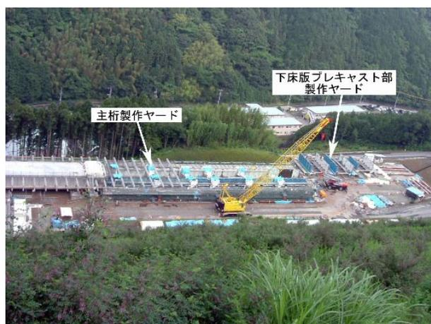
写真-1 主桁, 下床版プレキャスト部製作ヤード
