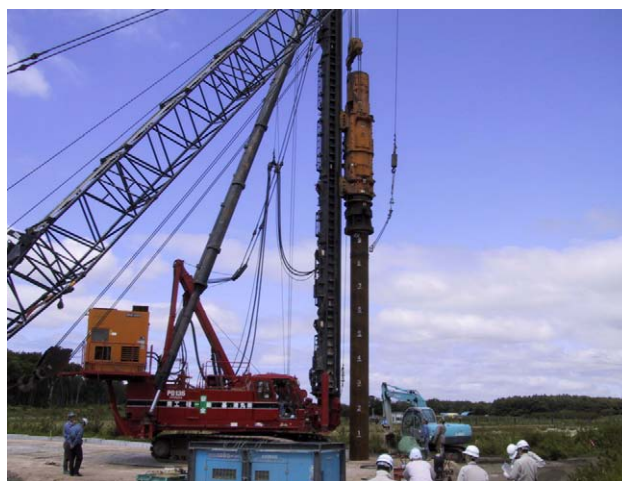
写真-1 鋼管杭打設状況
