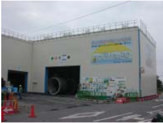
写真-1 防音ハウス
