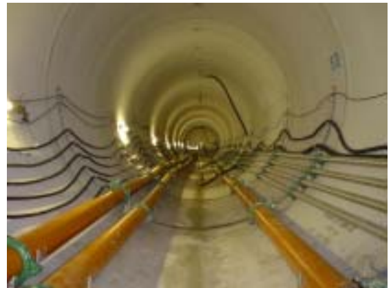
写真-4 管内状況
