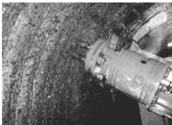
写真-5 ボルト出し状況
