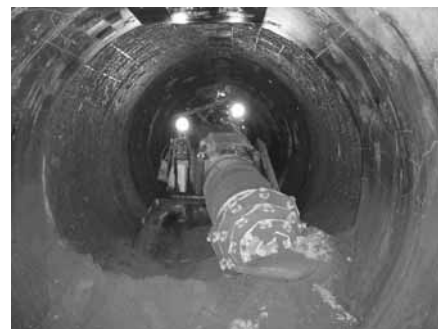
写真-3 二次覆工撤去状況
