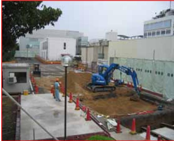
写真-1 砂置換状況
