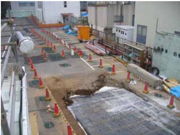
写真-6 トンネル部地中貫入完了
