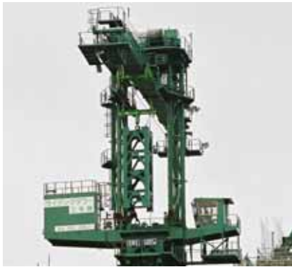
写真-9 マスト接続状況
