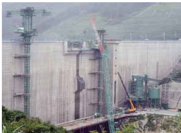
写真-14 解体状況
