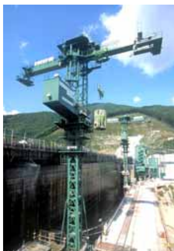
写真-7 コンクリート バケット上昇状況
