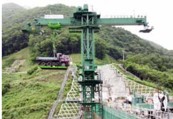
写真-13 10t ダンプトラック搬入状況
