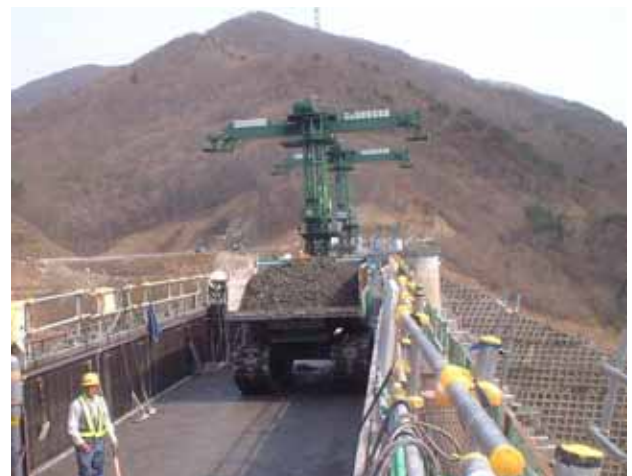
写真-12 不整地運搬車(くるくるダンブ) による堤頂部運搬状況
