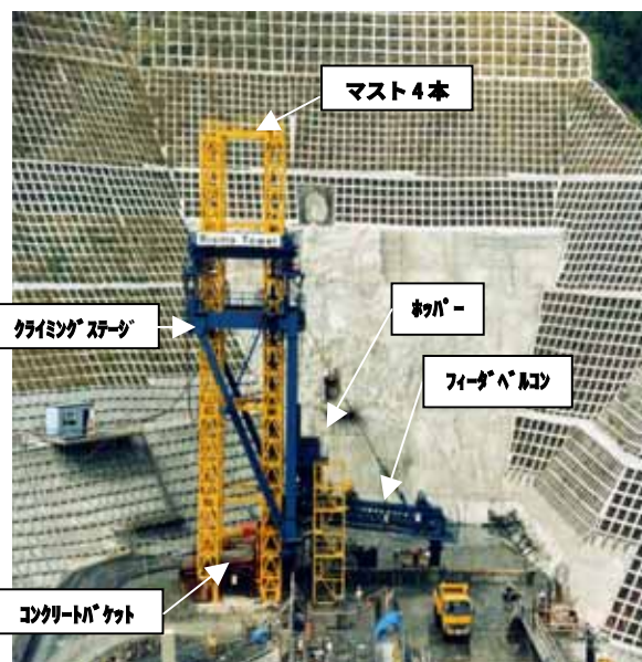
写真-2 ライジングタワーⅠの使用状況
