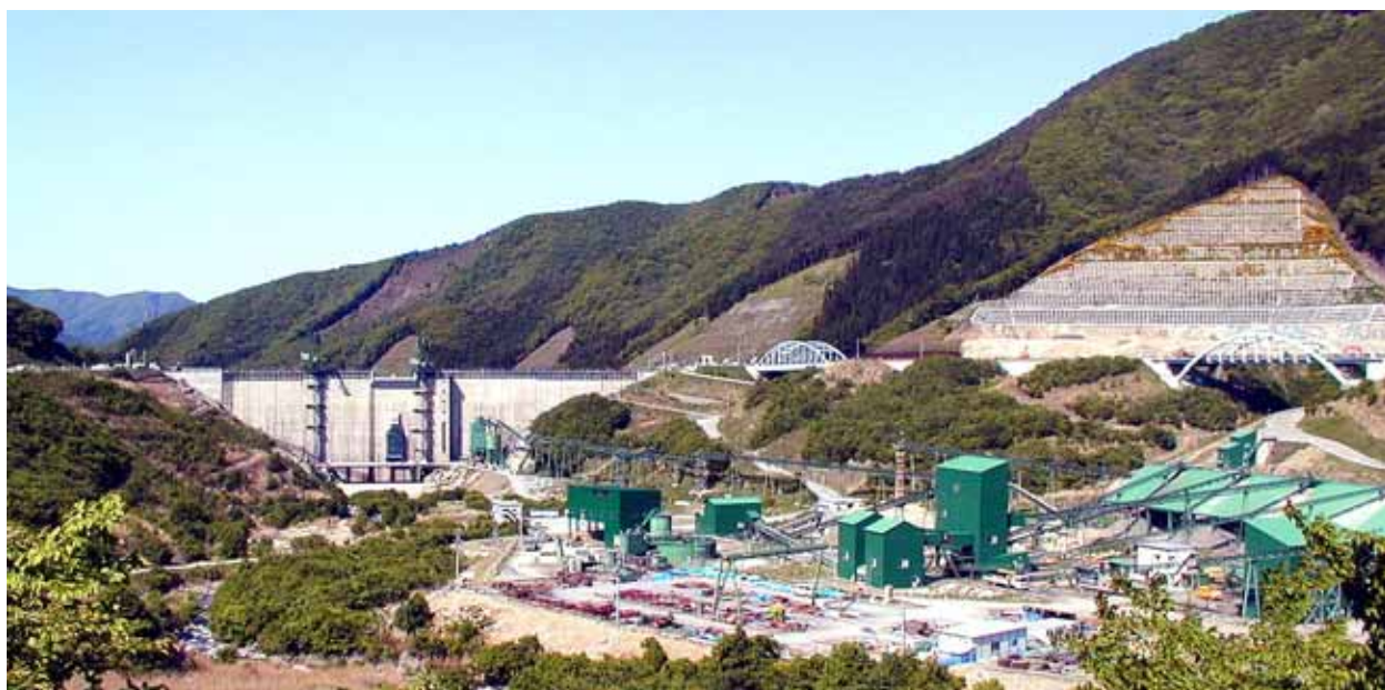
写真-3 鷹生ダム 全景
