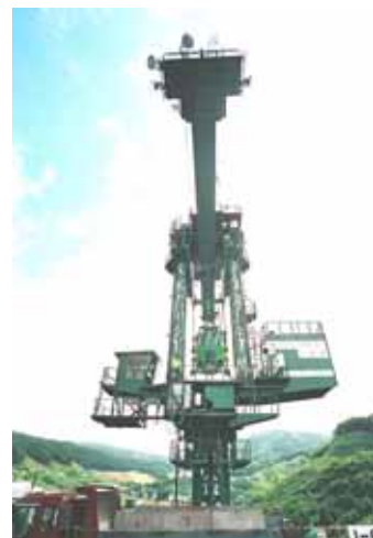
写真-8 水平移動状況
