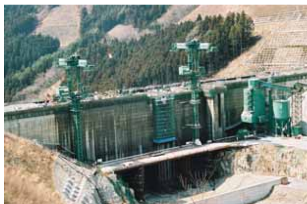
写真-4 施工全景
