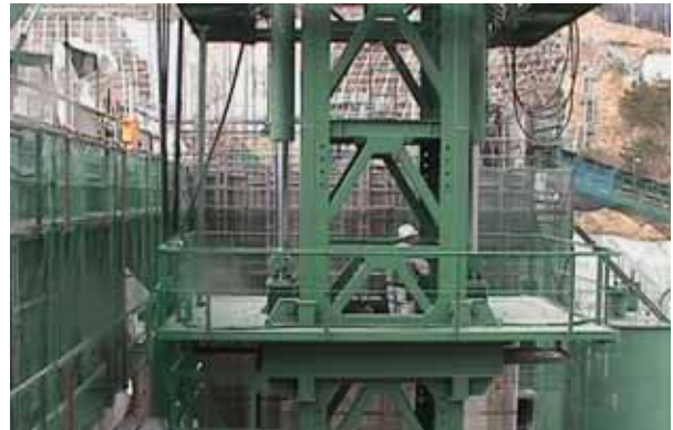
写真-10 ステージ上昇状況
