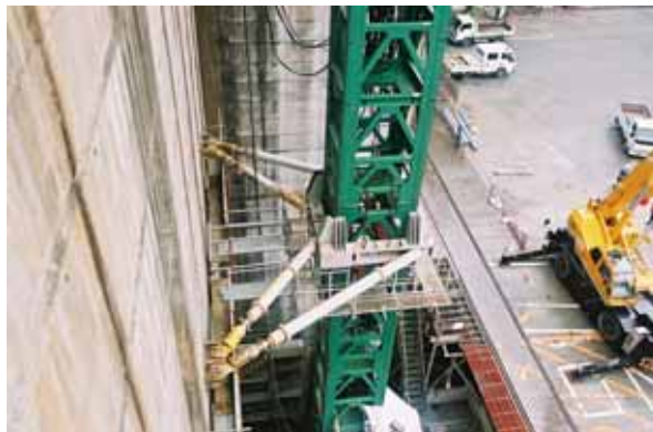
写真-11 中間支持金具設置状況
