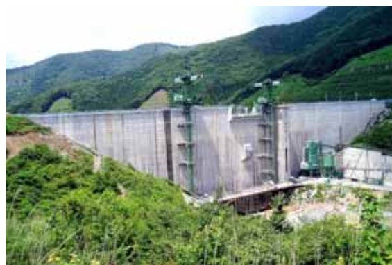
写真-5 打設完了状況
