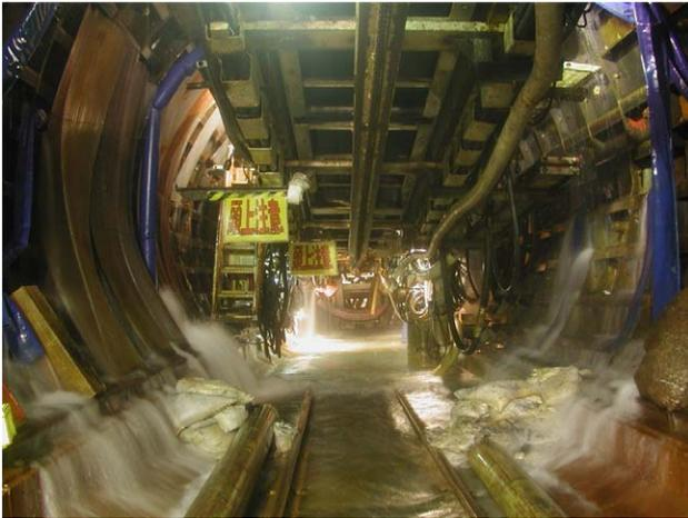
写真-1 先進坑TBMテール部の湧水状況
