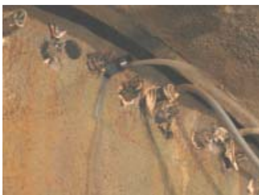
写真-2 湧水状況 (6k417m)
