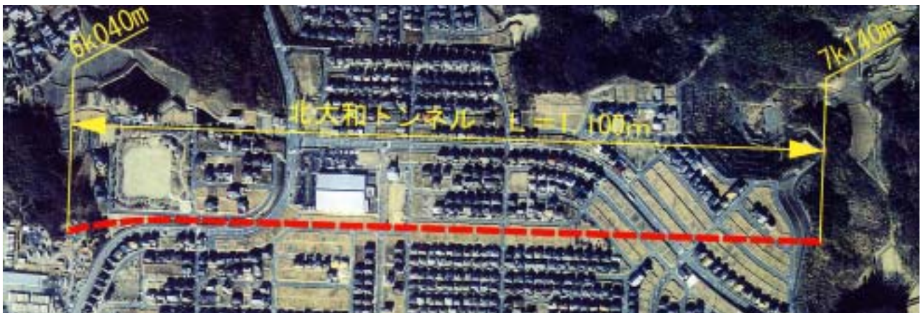
写真-1 トンネル位置地上状況
