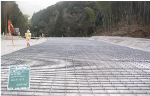
写真-3 補強鉄筋敷設状況
