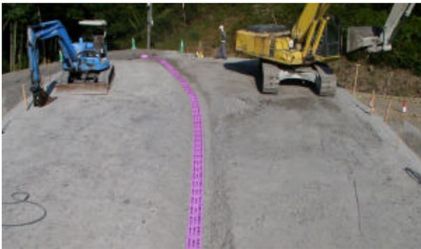
写真-4 鉄筋保護用目印テープ設置状況
