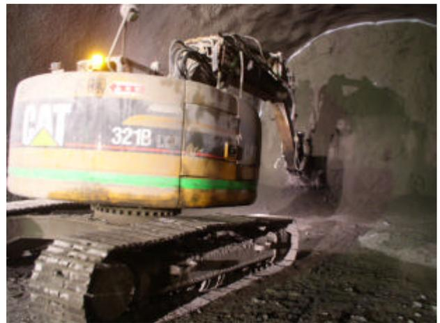
写真-5 トンネル掘削状況（ツインヘッド使用）
