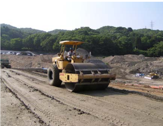
写真-4 振動ローラによる解砕状況
