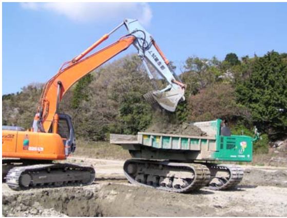
写真-3 バケット式解砕機による解砕状況
