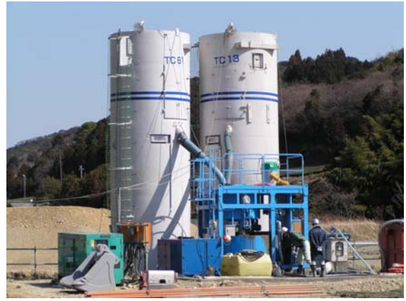
写真-1 トレンチャーによる初期固化状況
