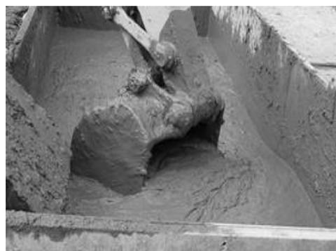
写真-1 貯泥状況（泥土圧シールド）
