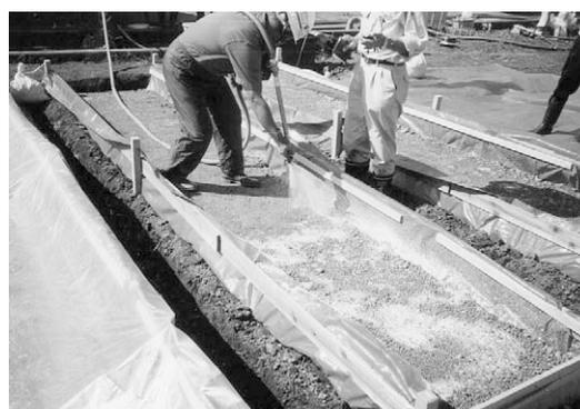
写真 - 1 液状マルチング散布状況
