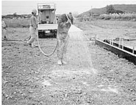
写真 - 3 液状マルチング施工状況
