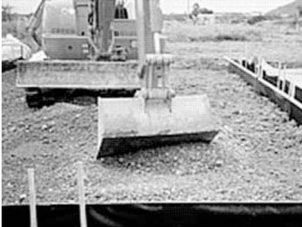
写真 - 2 造粒マルチング施工状況
