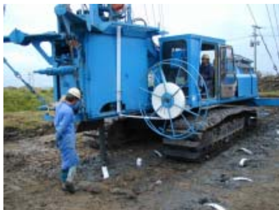
写真-5 打設状況
