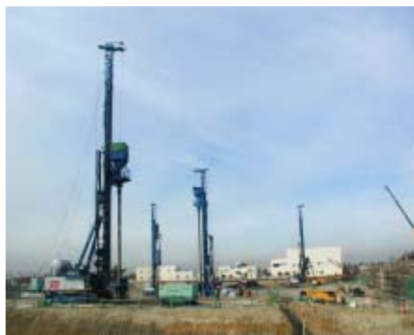
写真-1 地盤改良工事
