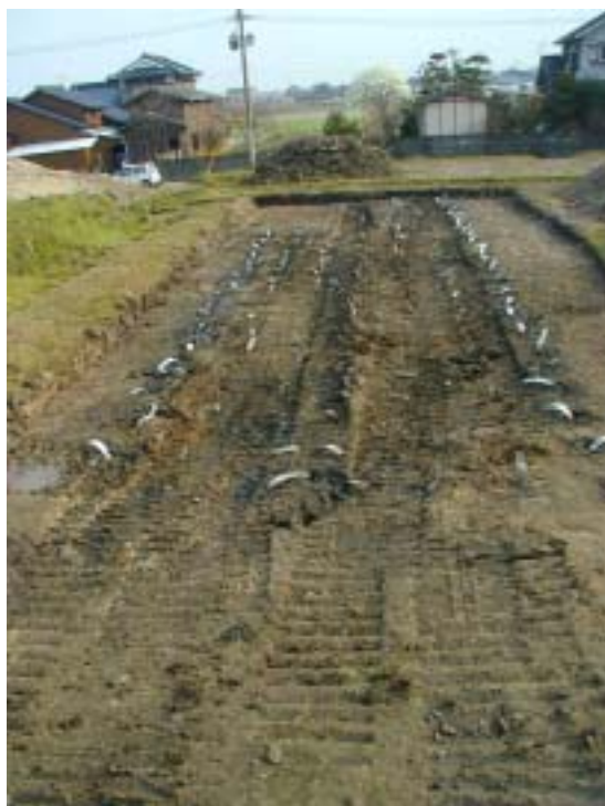
写真-6 打設完了
