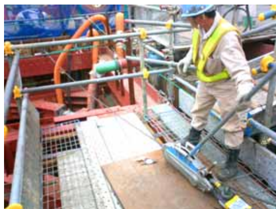
写真-2 チルホールによる躯体牽引状況
